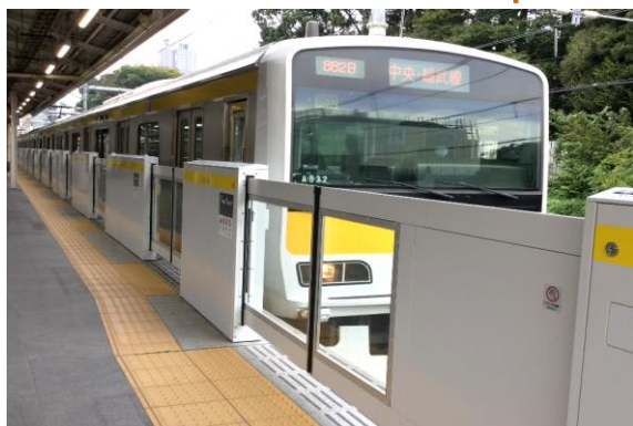
従来型のホームドア(中央・総武(各駅停車)線 千駄ヶ谷駅)
