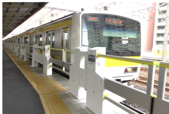
スマートホームドア®(中央・総武(各駅停車)線 亀戸駅)
